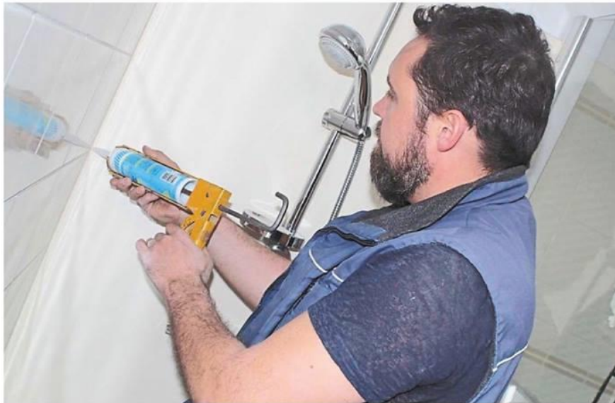
Comme une quarantaine d'entreprises artisanales en Mayenne, celle d'Alexandre Bergère est classée handibat, c'est-à-dire formée pour répondre aux besoins d'accessibilité des personnes âgées ou handicapées. Ici, Alexandre Bergère met la dernière main à l'installation d'une douche à l'italienne dans l'habitation d'une personne âgée.
